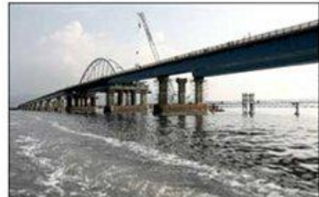
جاده میانگذر / پل میانگذر روی دریاچه ارومیه
